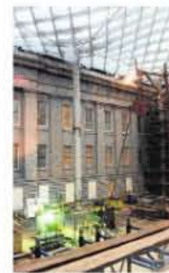
Een W voor het atrium van het Paleis op de Dam op 1 april.
